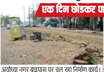
अयोध्या नगर बाइपास पर चल रहा निर्माण कार्य।
